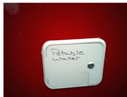
Entrada de agua potable
